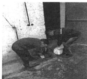
用消防沙袋围堵水沟
