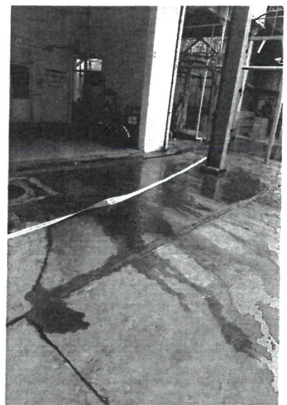
接消防水带至应急池
