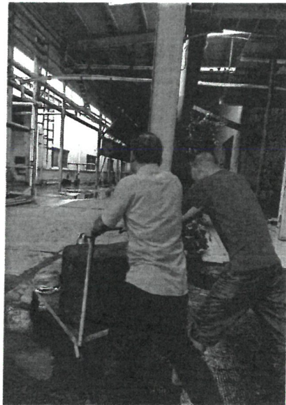
启用应急抽水泵
